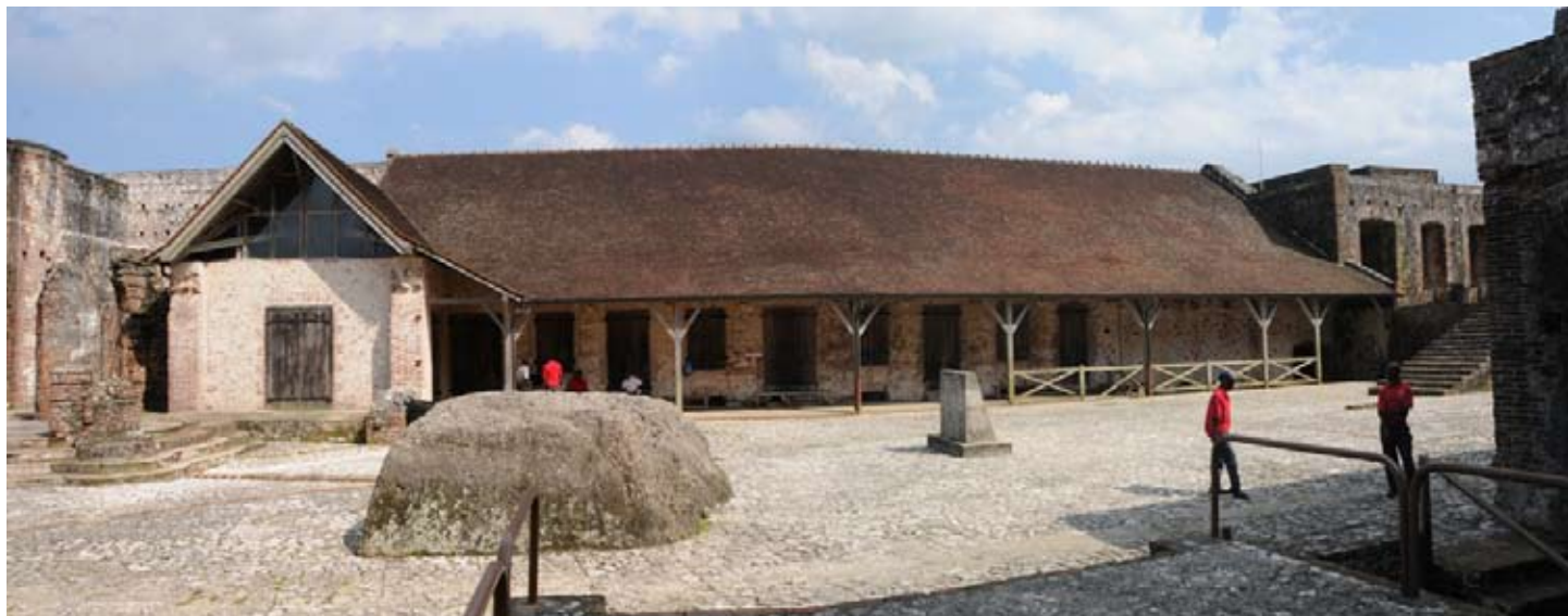
• Le Quartier des Officiers (au fond) et la cour centrale de la Citadelle Henry
