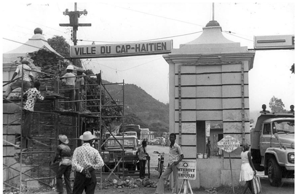
• Restauration de la Barrière-Bouteille au Cap-Haïtien (1982)
