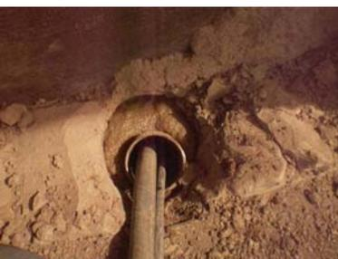
Tras estudios y diagnósticos estructurales realizados durante el 2011 y 2012, la OHCH acordó la necesidad de reforzar la estructura del inmueble mediante la perforación y fundición de micro-pilotes y las correspondientes vigas de cierre para el recalce de la cimentación. Estos trabajos, aún no iniciados por falta de equipamiento, serán llevados a cabo por la Empresa Nacional de Investigaciones Aplicadas (ENIA), experta nacional en estas intervenciones.
